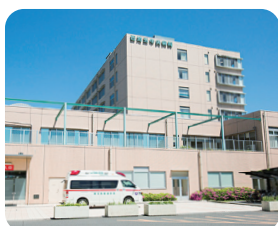
国立病院機構西埼玉中央病院
