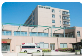
国立病院機構西埼玉中央病院
